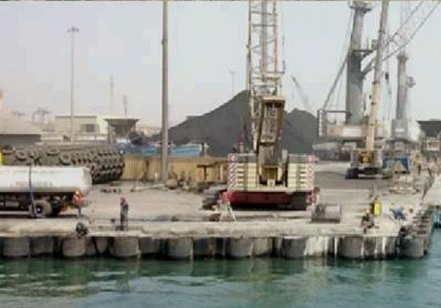
**Etudes, fournitures et réalisation d'un combi-wall pieux/palplanches de 350ml le long des quais existants. Battage de 122 pieux Ø1219mm de 23m, vibrofonçage de 121 palplanches AZ23-800 double. Remplissage en béton du gap entre le combi-wall et le quai existant, coulage massif des défenses et zone de raccordement entre les dalles de couvertures et quai existant. Montage et installation de 13 défenses de type tronconique, pose et alignement de 42 dalles de couvertures**
