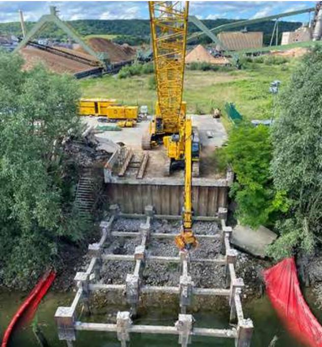
**Rénovation de pieux pour les ducs d'albes d'accostage, création de ducs d'albes équipés de défenses et de bollards. Démolition et évacuation de la plateforme et du muret périphérique en béton armé. Fourniture et pose d'une plateforme métallique avec garde-corps, butée sur un côté, échelle de service, coulage d'un dallage d'accès.**
